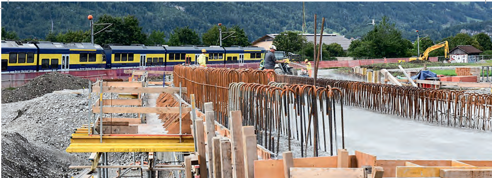
Direktanschluss: bereits betonierte Brückenplatte bei der Unterführung.
