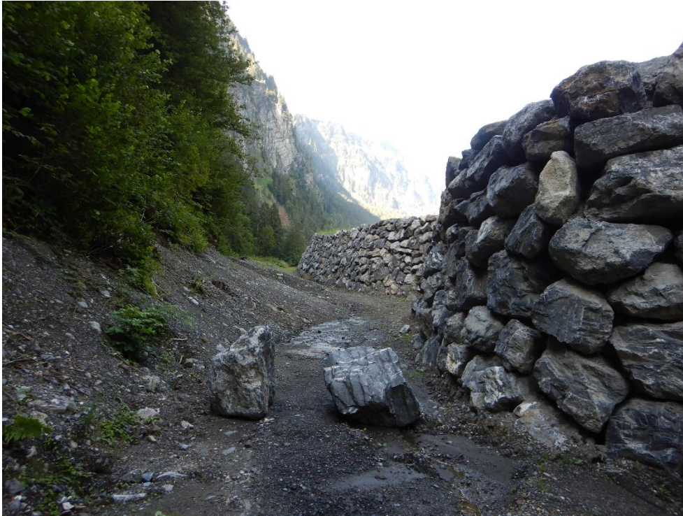
Abbildung 2: Übersicht des Geländes bergseits des Dammes inkl. Unterhaltsweg.
