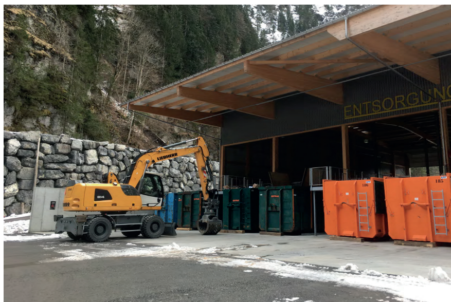
Abb. 6 Der Entsorgungshof mit dem dahinterliegenden Steinschlagschutzdamm (eigenes Foto März 2020). Gut ersichtlich eine der grossen Maschinen, die zur Bewirtschaftung der Sammelbehälter, Mulden und Lagerflächen benutzt wird.
