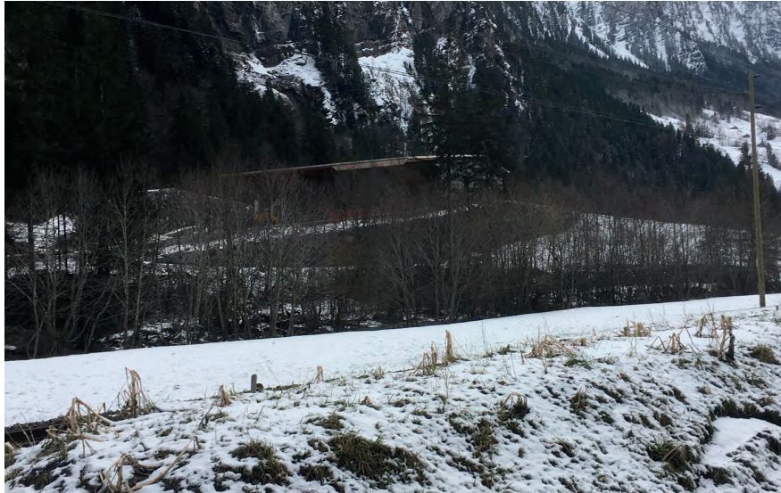
Abb. 7 Blick von der Bahnlinie in Richtung Entsorgungshof mit der Stützmauer vorne und dem Steinschlagschutzdamm hinten (eigenes Foto März 2020).
