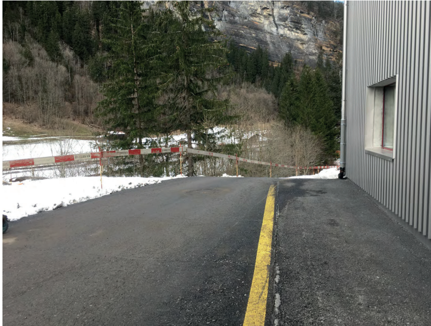
Abb. 3 Sicht in östliche Richtung bei Ausfahrt aus dem Entsorgungsgebäude. Das Foto zeigt, wie schlecht die Sichtweiten in östlicher Richtung sind und wie wichtig die zweite heute noch abgesperrte Fahrbahn für einen sicheren Betrieb ist (eigenes Foto; März 2020).
