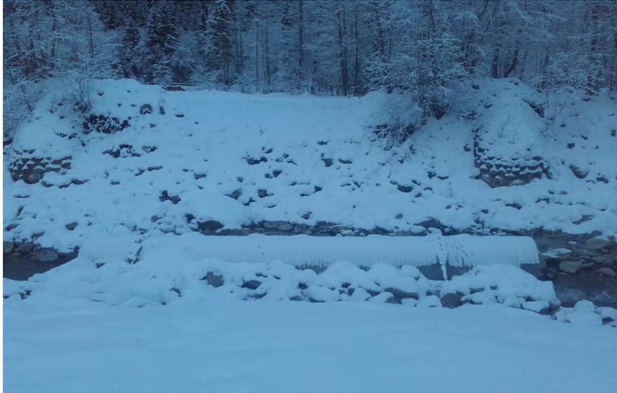
Abb. 18 Stahlrohr L ca. 5 m, welches bisher mit Schnee von der Strassenräumung überdeckt wurde (wird in Zukunft analog Anhang A ausgeführt)
