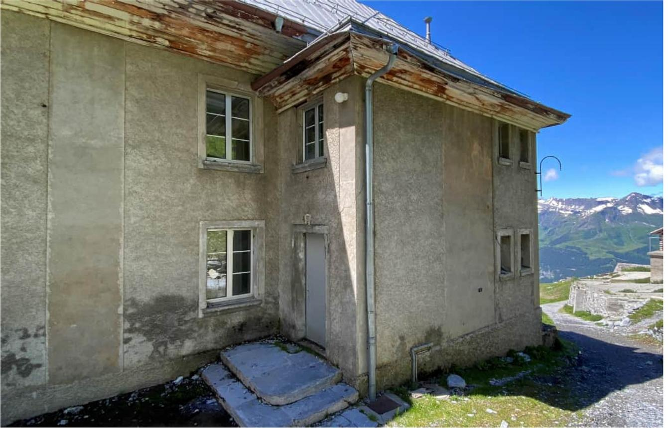
*Abbildung 23 Eingangsbereich Nord, Schäden an belasteten Stellen*
