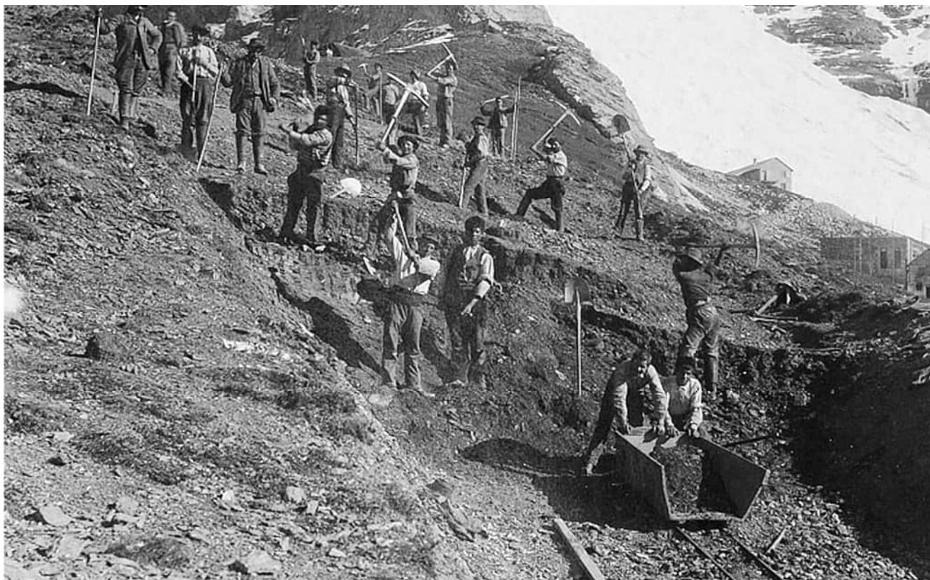
Abbildung 1: Bauarbeiten am Bahntrasse knapp unterhalb der Station Eigergletscher, wohl 1898 (Ausschnitt).
